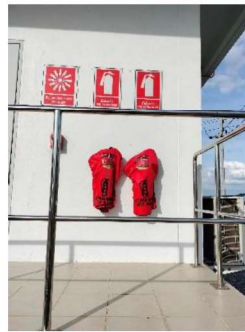
ภาพที่ 2-2 ถังดับเพลิงแบบเคมีผงที่สถานีควบคุมความดันและวัดปริมาณก๊าซธรรมชาติ (MRS)
